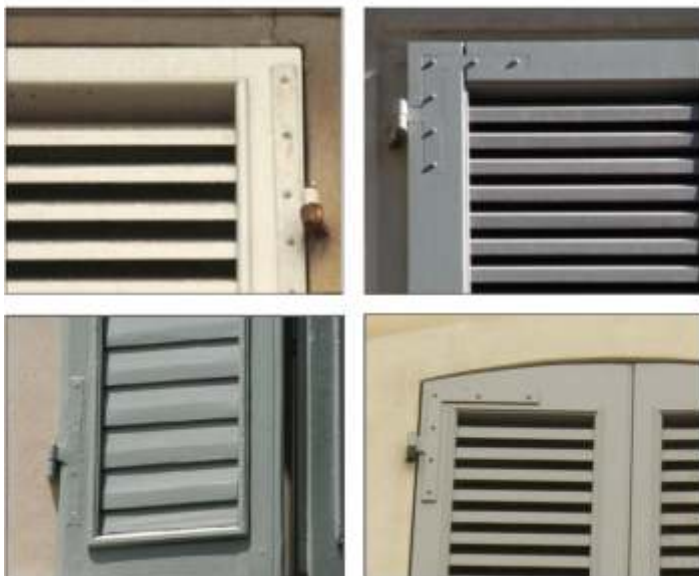
ANGOLARI METALLICI INTEGRATI NEL SERRAMENTO
