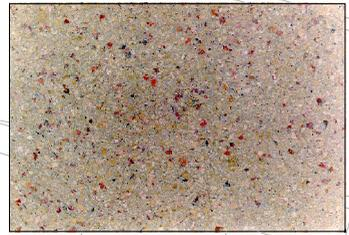
**C** PAVIMENTAZIONE DEL SOTTOPORTICO ESEGUITA IN GRANIGLIA DI CEMENTO (MATERIALE DA SOSTITUIRE)
