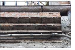
**TIPOLOGIA NON COMPATIBILE REALIZZATA IN ELEMENTI LIGNEI SENZA STRUTTURA DI PROTEZIONE E FINITURA**
